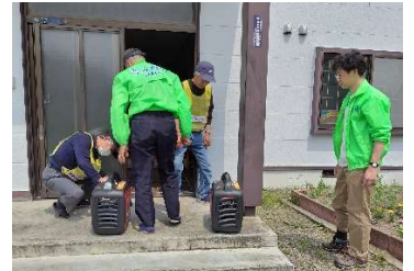
発電機の点検
